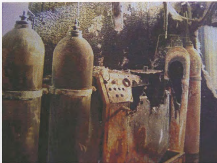
Incendie d'une station de transfert d'oxygène
